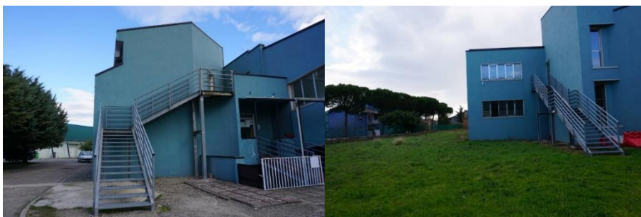
Uscita di emergenza piano primo, lato sud
